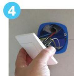
4 Fixation de l'appareillage
